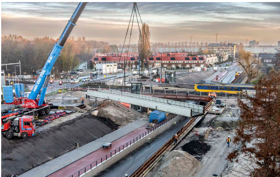
Wegtakelen van tijdelijke spoorbrug bij station Diemen.
