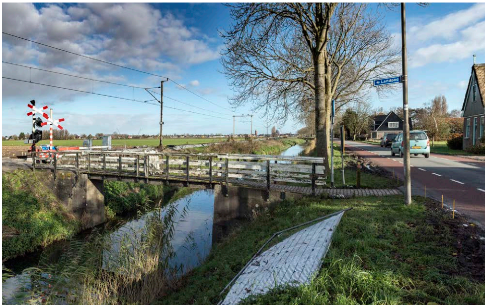
Overweg in Westwoud tijdens verbetering van de beveiliging door middel van Automatische Overpadbomen.
